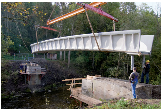
Bild 4. Fußgängerbrücke aus Textilbeton mit ca. 16 m Spannweite in Kempten während der Montage des Überbaus Fig. 4. TRC pedestrian bridge with app. 16 m span in Kempten during erection of superstructure
