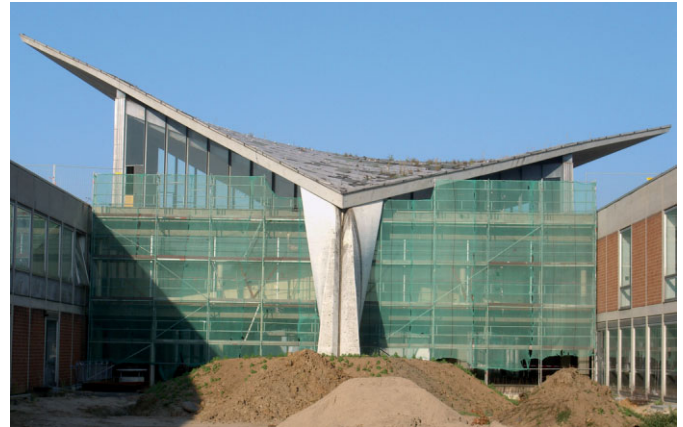
Bild 5. Die Tragfähigkeit dieses Schalentragswerks an der FH Schweinfurth wurde durch die Verstärkung mit Textilbeton dauerhaft gesichert
