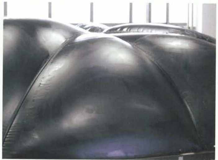
Die Schale wird mit einer pneumatischen Membranzstützkonstruktion geschalt
